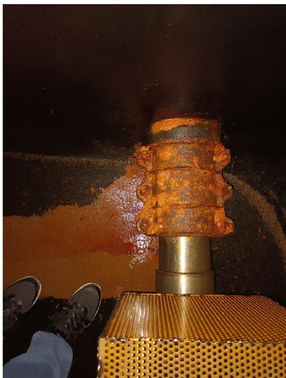
*Interno della vasca attualmente in uso per il prelievo dell'acqua dalla pompa che la spinge in rete. Il sistema permette anche un eventuale recupero dalla rete.
